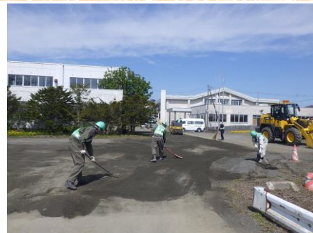
▲ 敷地整備の様子
